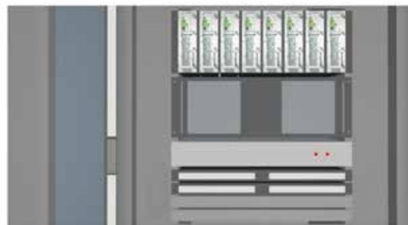
Die zentrale Rufanlagen-Installation im 19"-Verteilerschrank besteht aus Bedienrechner, System-Switch, USV und Systevo Control Zentraleinheit.
