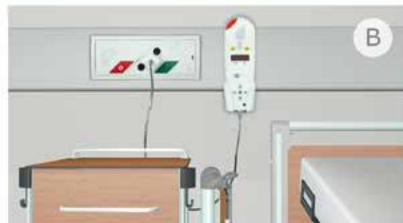
Bettenmodul als multifunktionale Schnittstelle zu einfachen und integrierten Patienten- Bediengeräten ermöglichen die einfache Steuerung von ELA, Patienten-TV, und Raumsteuerung (Licht, Jalousie...) sowie der diskreten Pflegekommunikation.
