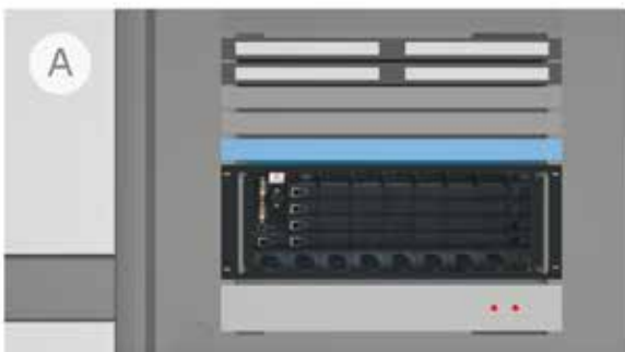
Die Systemerweiterung mit ITK-Mehrwertdiensten im 19" Verteilerschrank besteht aus Servern, System-Switch und USV.
